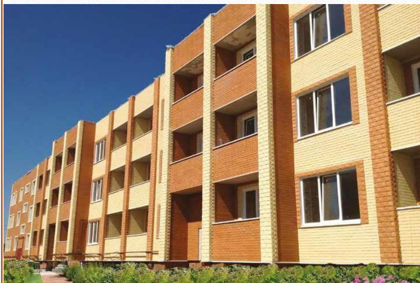
Фасад: Клинкер П и 4 Углы и Балконы: Песчаник 4 Окна: Малый Сколотый Камень П и 4
