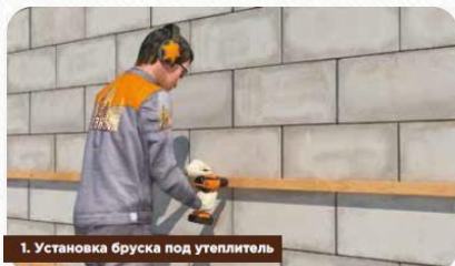
1. Установка бруска под утеплитель
