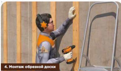
4. Монтаж обрешетной доски
