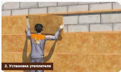
2. Установка утеплителя
